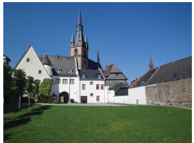
Marktstraße 23 nach der Sanierung und der neue Josef-Staab-Platz, Fotos: Nassauische Heimstätte
