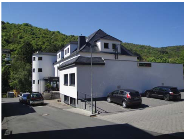
Das sanierte Lorcher Bürgerhaus, im Vordergrund die neu geschaffene Stellplatzanlage, Foto: Nassauische Heimstätte
