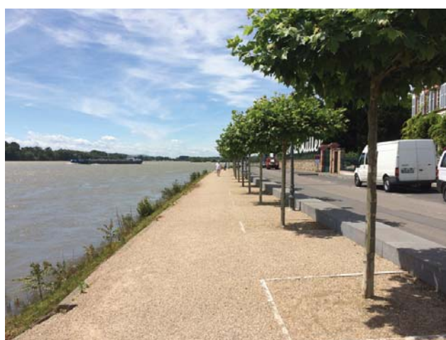
Der Abschnitt zwischen Sebastiansturm und Matheus-Müller-Straße vor und nach der Erneuerung, Fotos: Nassauische Heimstätte
