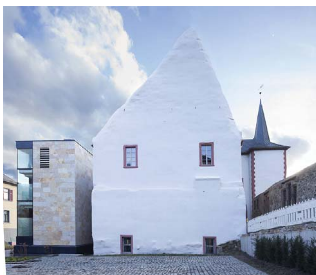
Das Hilchenhaus nach der Sanierung, Fotos: Walter Vorjohann
